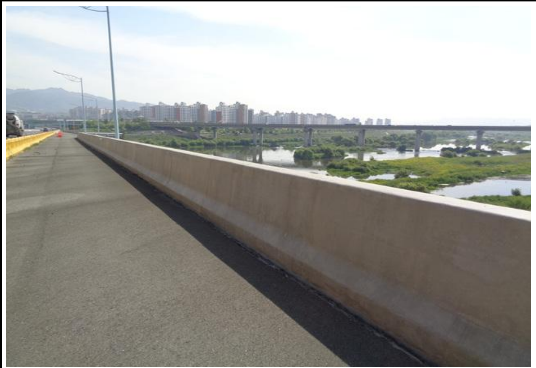
난간 및 방호벽 전경
